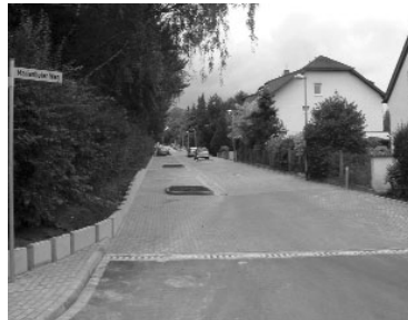
Ausbau des Mariendorfer Weges
